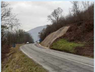
La scarpata risanata nella località Pomerlino di Sabbio Chiese
