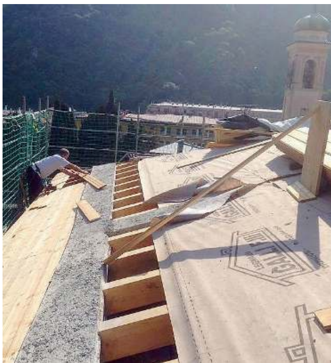
A Gardone. Gli alloggi per disabili saranno nell'ex Palazzo Grazioli
