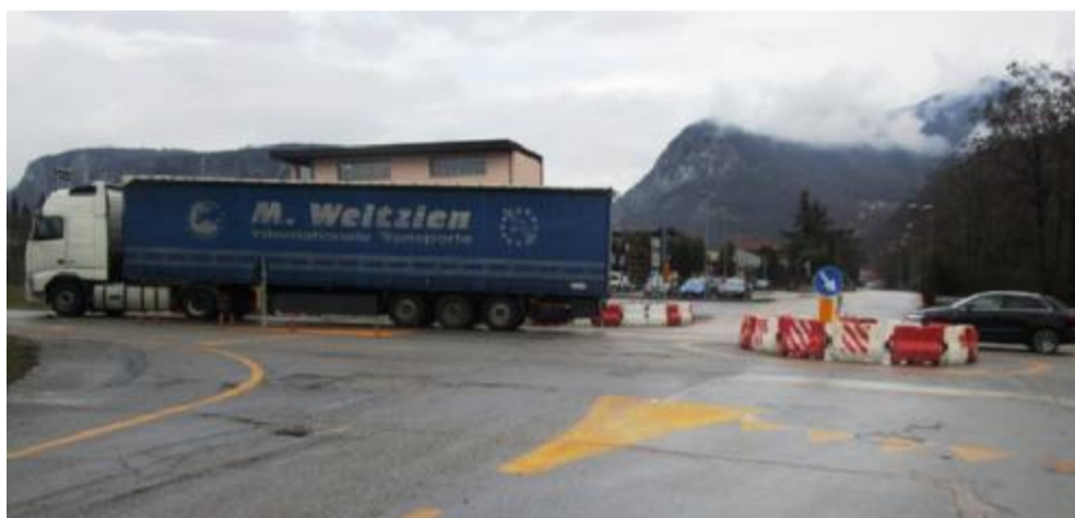
La rotonda di plastica che è stata posizionata dall'Anas allo svincolo della Tangenziale di Vobarno
